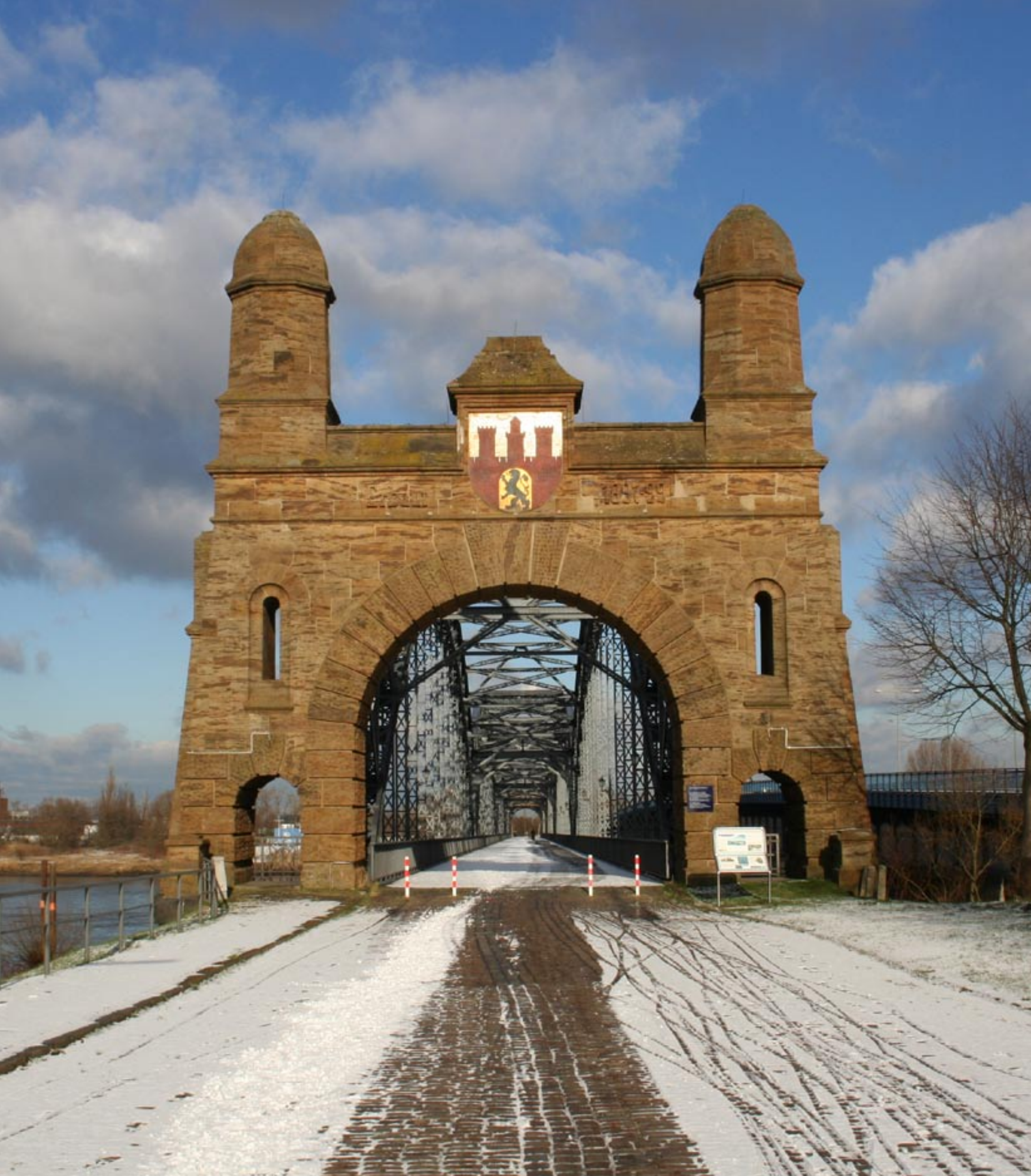
Alte Harburger Elbbrücke
