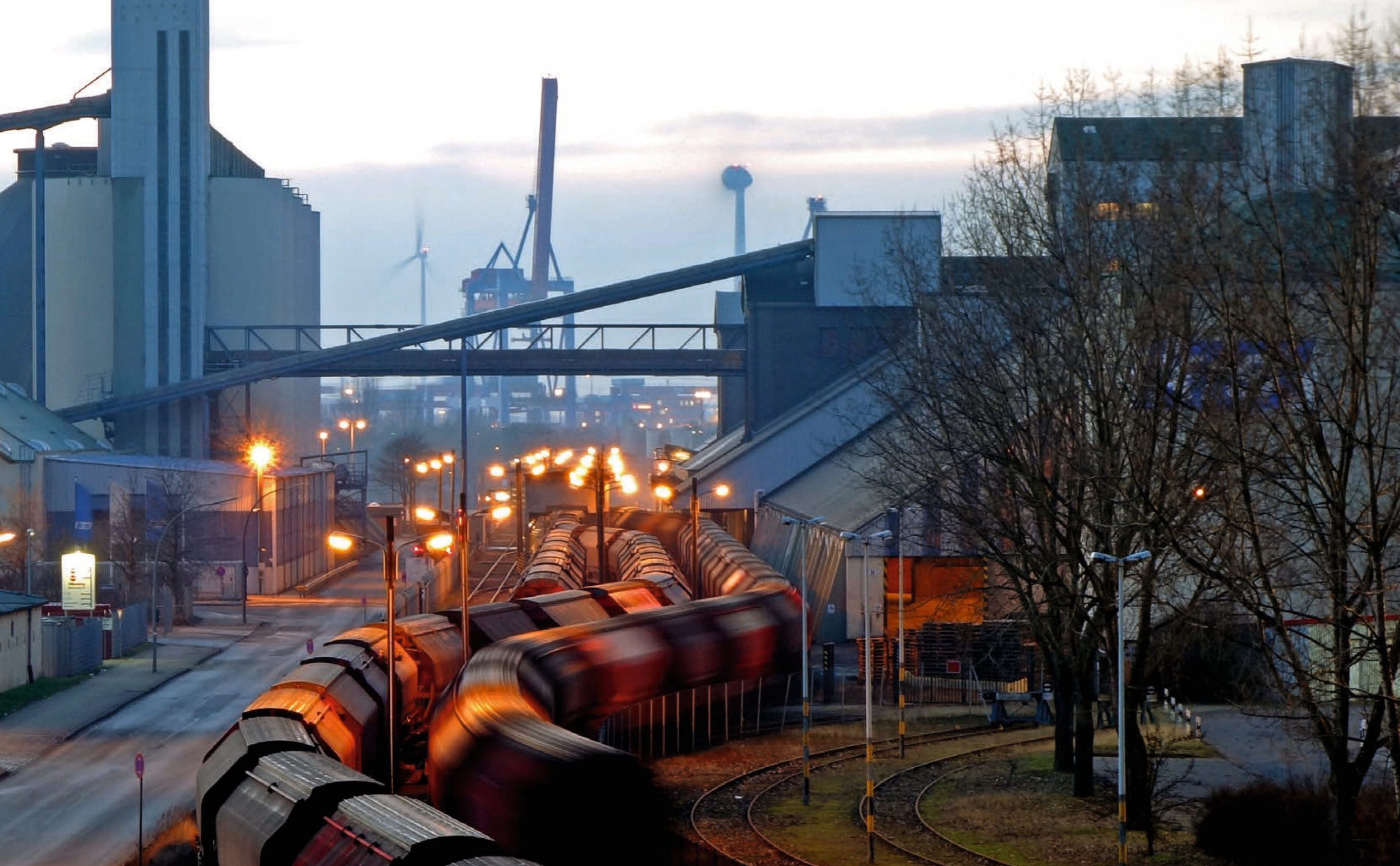
Gleisanlage des Silos am Rethhafen
