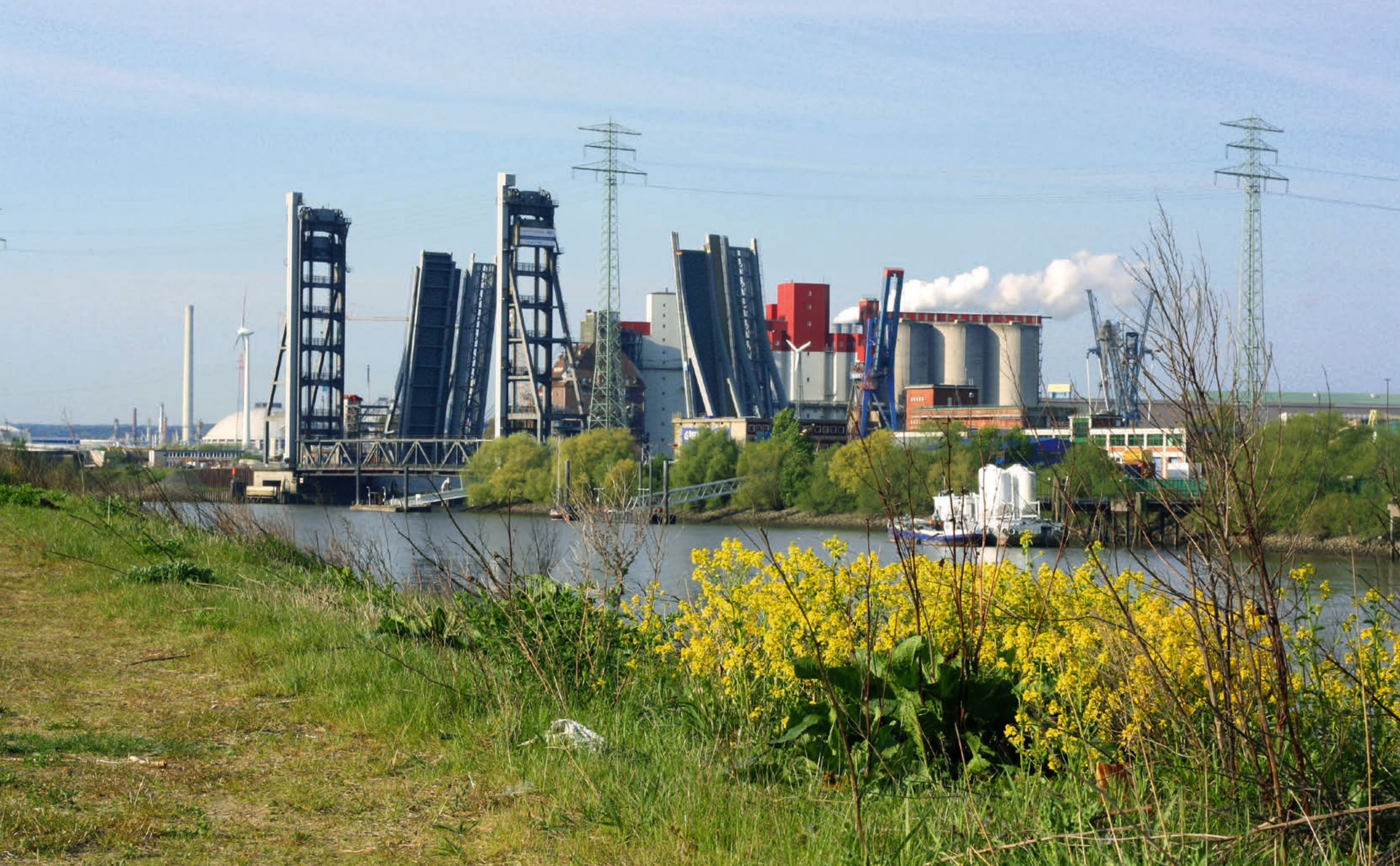
Alte und neue Rethhubrücke
