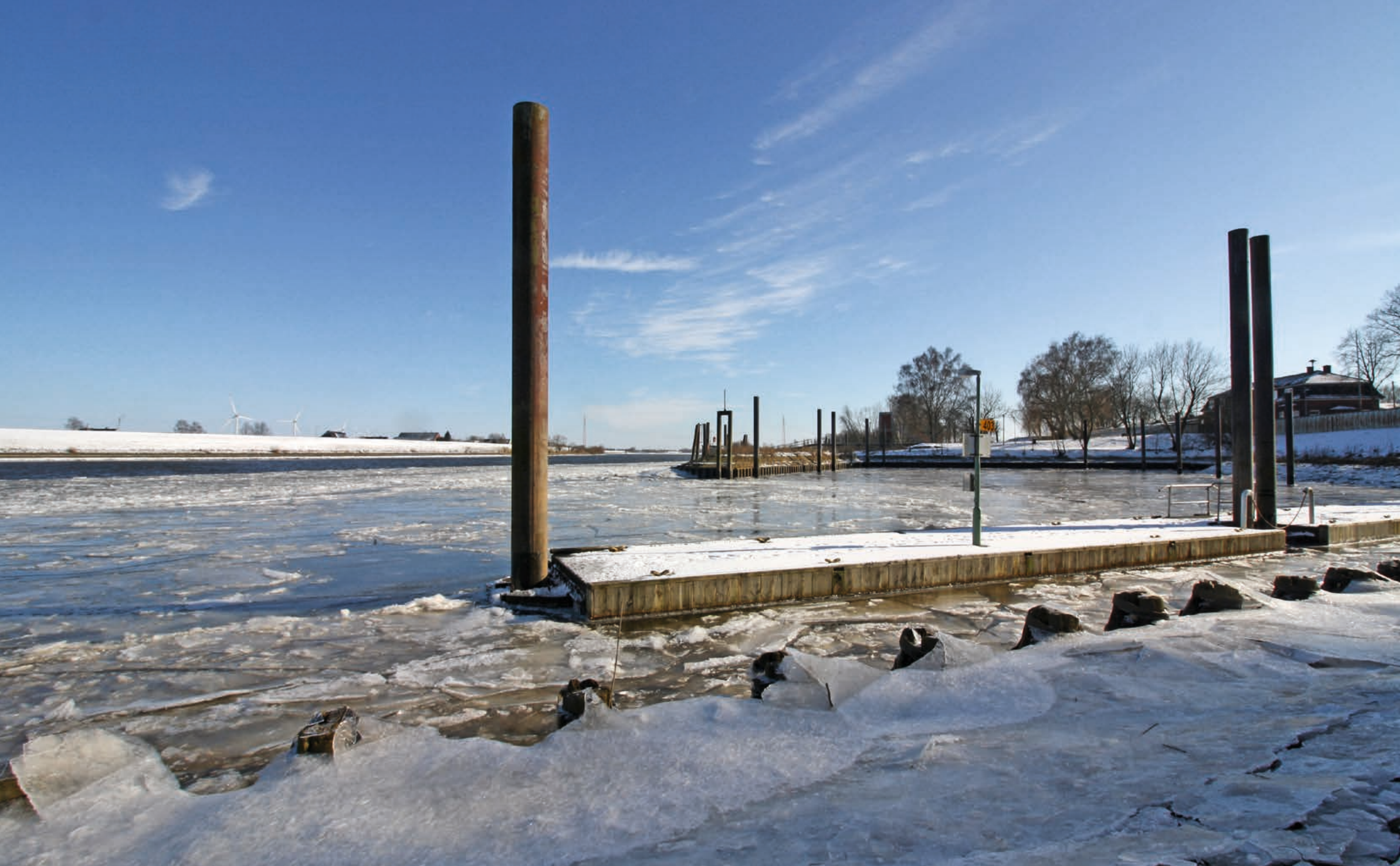
Norderelbe bei der Stackmeisterei
