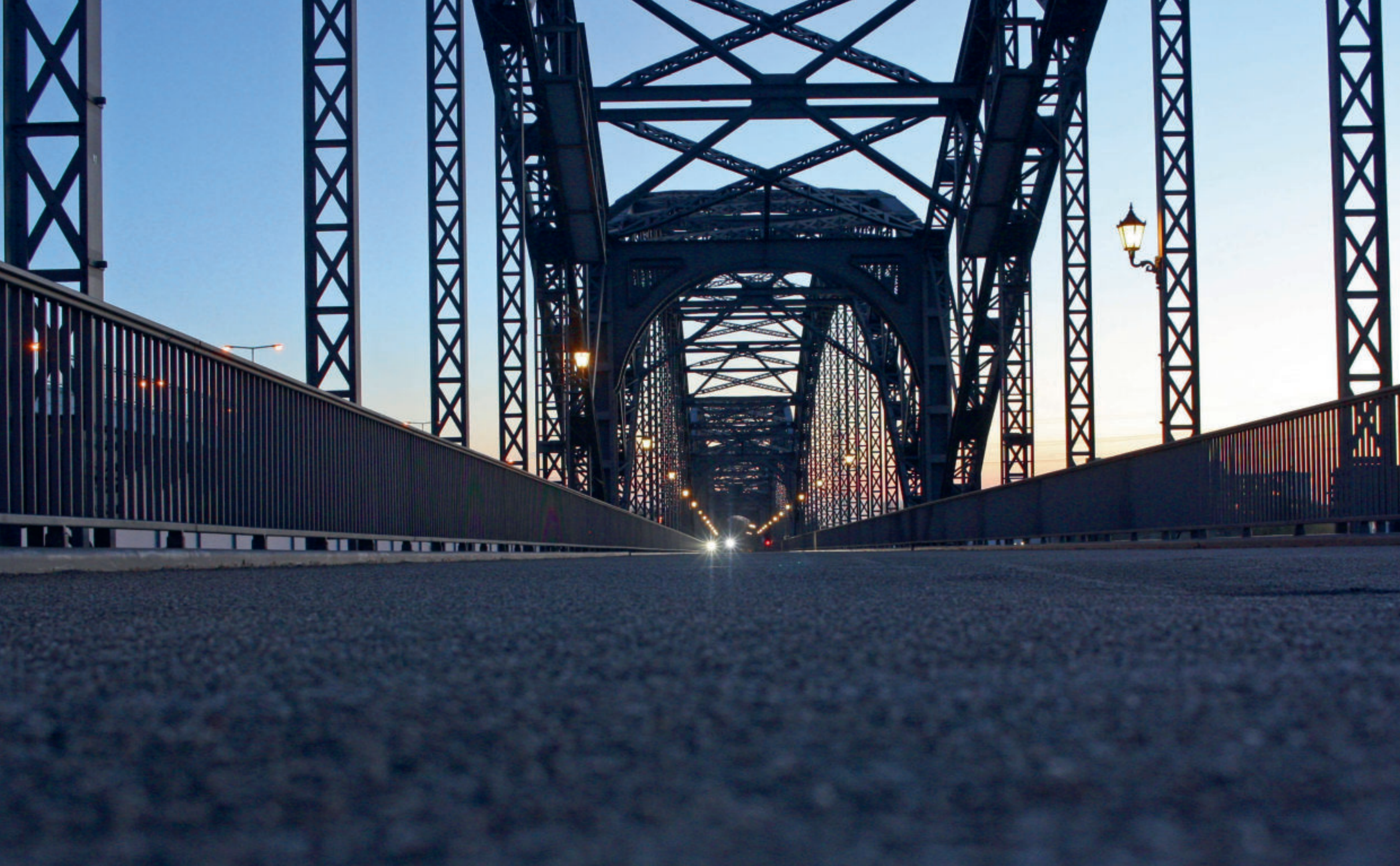
Alte Harburger Elbbrücke
